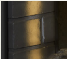
Détail du panneau de briques latéral
