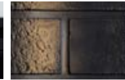
Détail du panneau de briques latéral
