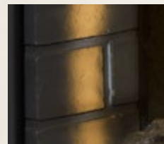
Détail du panneau de briques latéral
