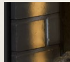
Détail du panneau de briques latéral
