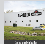
Centre de distribution
